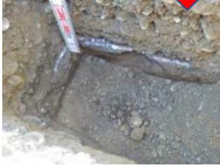
作業完了石灰散布による車両タイヤ付着防止
